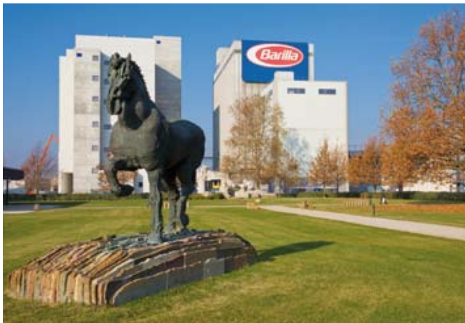
Stabilimento Barilla di Pedrignano (Parma).
